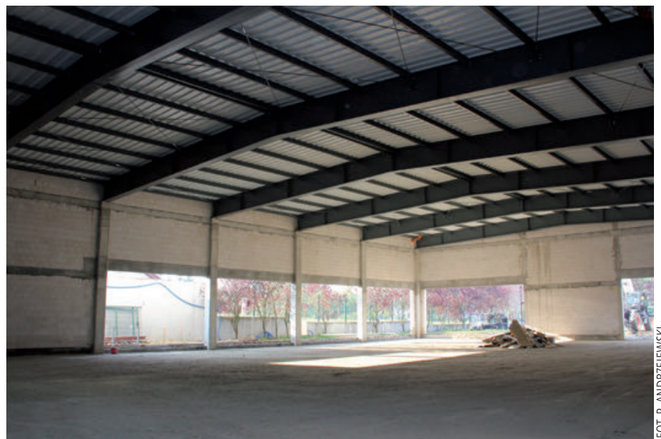
Budowana hala sportowa przy SP 2 w Suchym Lesie
