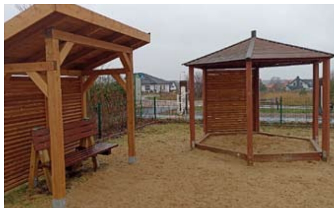
Zielątkowo – plac zabaw przy ul. Sportowej. Zamontowano drewniane osłony przeciwsłoneczne dwóch ławek i piaskownicy.
